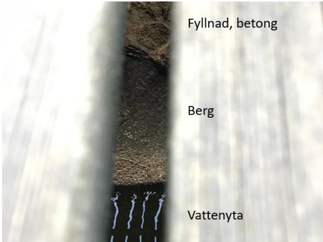
Figur 6. Bergyta vid vattenlinjen under kajkonstruktionen.
