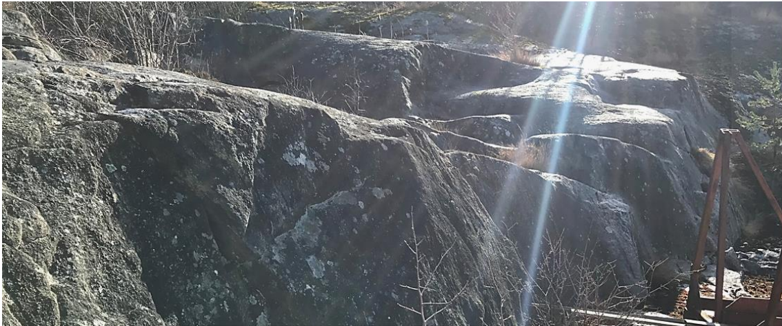
Figur 13. Inga lösa block påträffades i slänt B.
